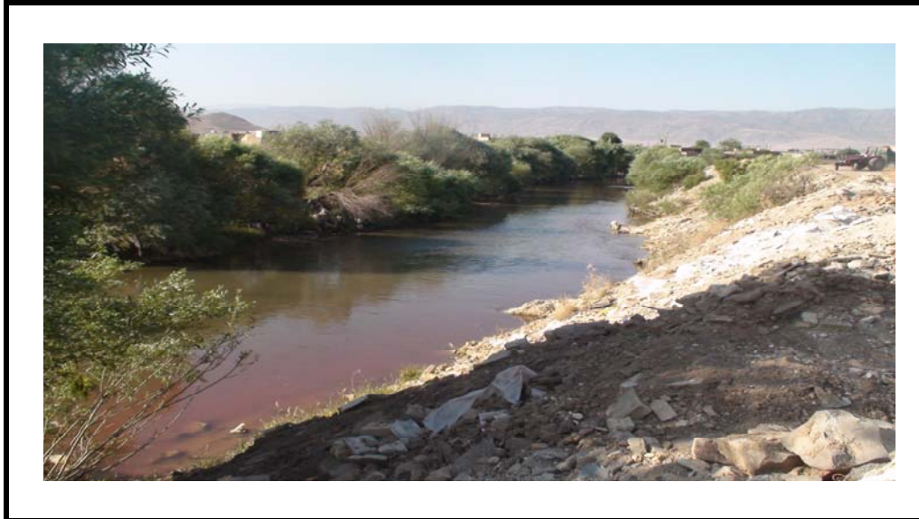
تصویر ۳-۴: درختکاری و ریختن سنگ لاشه و نخاله های ساختمانی در بخش خارجی قوس ماندرها (منطقه گیلوران)
